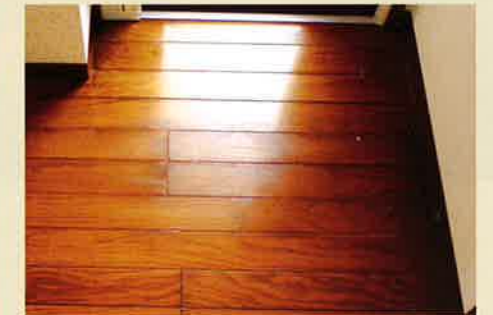
シミ・カビを除去し、着色・塗膜再生後、ペットコートを施工。ペットに優しく、汚れに強い床に生まれ変わります。
